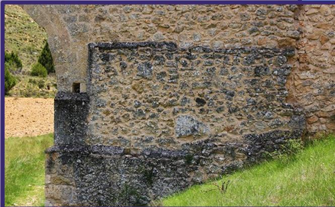
*Diferentes lienzos de mampostería. Hasta cuatro en disminución por secciones conforman el muro desde la base y el límite superior para la conducción del agua.*
