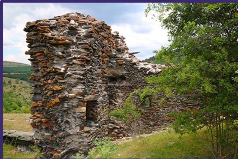
Vista interior de la puerta de acceso.
