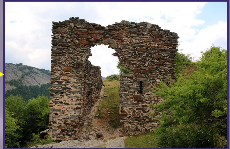
La entrada del portón resiste al paso del tiempo con lajas de pizarra y argamasa.
